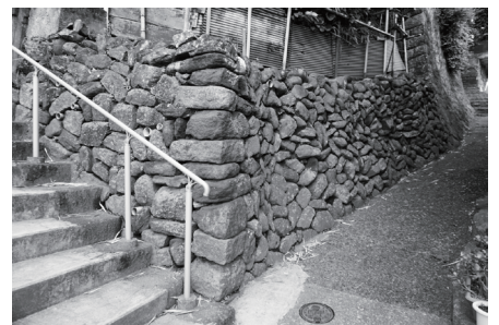
写真 3-9 野面石を用いた石積擁壁
