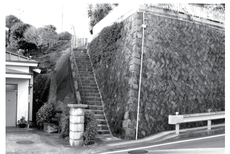
写真 3-6 擁壁に付属する階段
