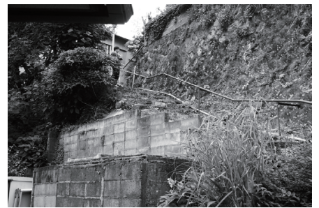
写真 3-7 段状の擁壁（西側斜面）
