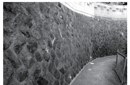
写真 3-8 ひだ状の擁壁（東側斜面）
