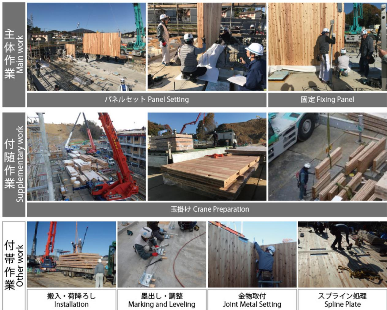
Fig. 4-9 作業工程の分類 Work classification
