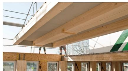
Photo 2-19 木とコンクリートによる複合パネルの施工
