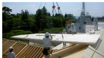
Photo 2-3 KLH で加工された CLT パネルを野地板として屋根に施工しているところ
