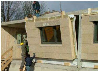
Photo 2-15 南街区の施工，大型木質パネルによる建て方
