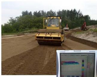
RTK/GNSSによる転圧管理
