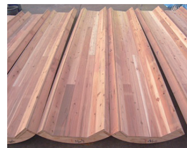
写真7 本実型枠（展開状況）
