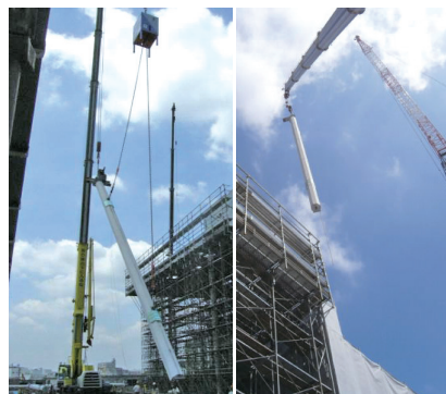
写真6 PC柱の縦移動 左）横置き柱を建て起こし、 右）定位位置に柱をセット
