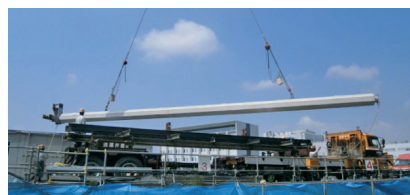
写真5 PC柱の横移動
