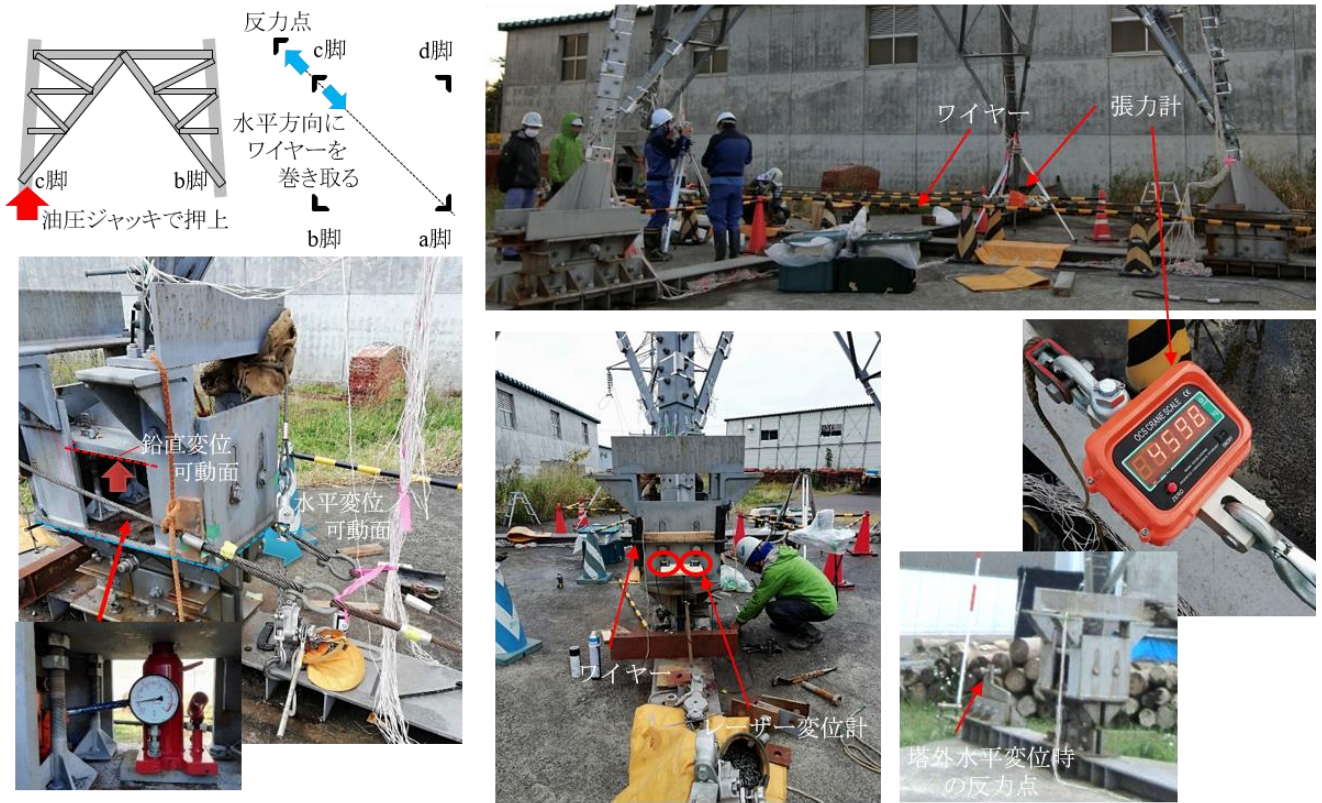
鉛直変位時には、この空間に油圧ジャッキを挿入
