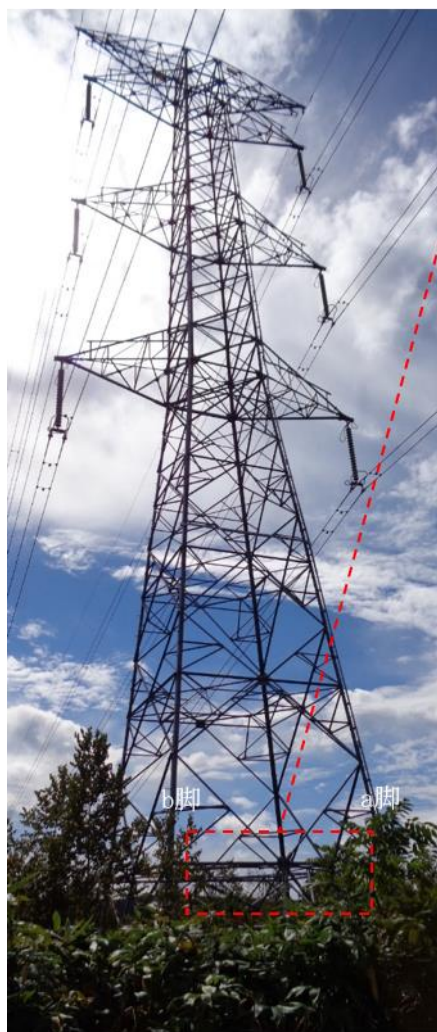
(a)対象鉄塔全景
