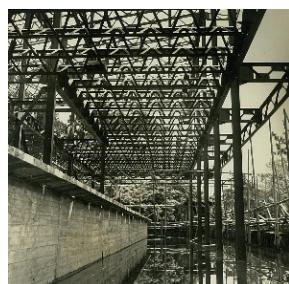
図 33. トラス梁施工時の写真 注 22
