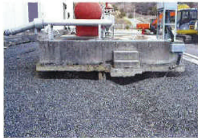
写真 1.2 埋戻土沈下による 基礎杭の露出状況 (女川原子力発電所) 1.5)
