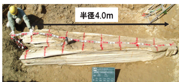
写真 2.4 大型径改良の例 (半径4.0m)
