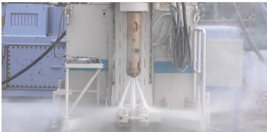
写真 2.9 ジェット削孔の状況
