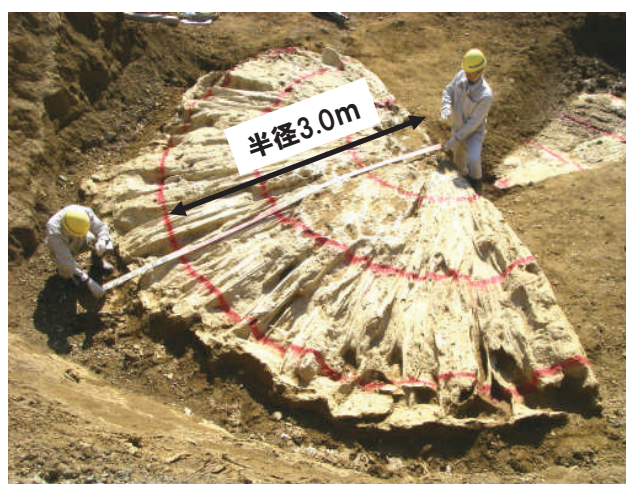
写真 2.5 大型径改良の例 (半径3.0m)
