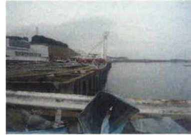
写真 1.3 物揚場護岸のはらみだしの 状況：拘束の大きいデリック クレーン位置と護岸変位の 違いが確認できる (福島第一原子力発電所) 1.5)
