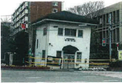
写真 1.1 浦安市の沈下 傾斜した交番 1.4)
