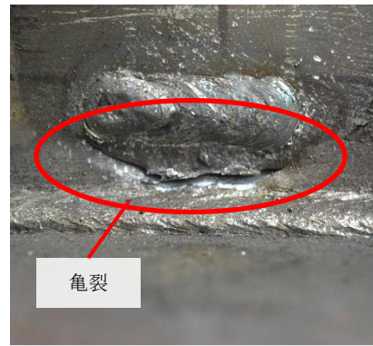
亀裂補修部に再度生じた亀裂
