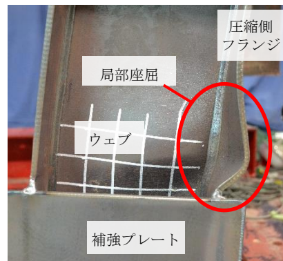
圧縮側フランジの局部座屈
