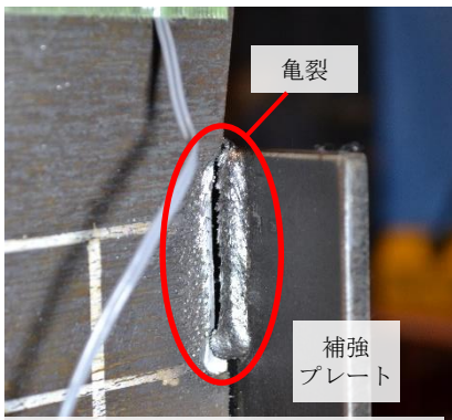
プレート溶接部に生じた亀裂
